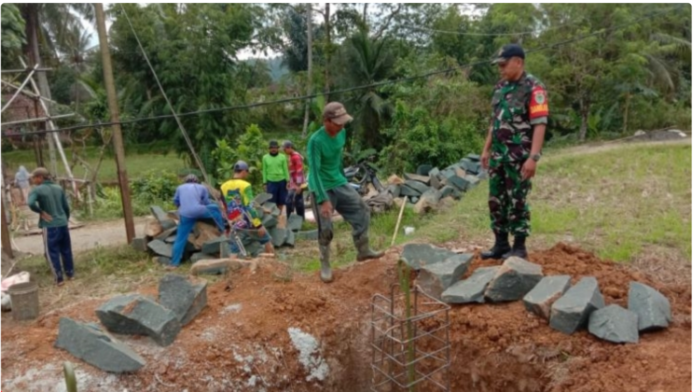
Giat Bakti Pembangunan Jembatan Gantung di Koramil Jampangkulon Bantuan Pangdam III/Siliwangi
