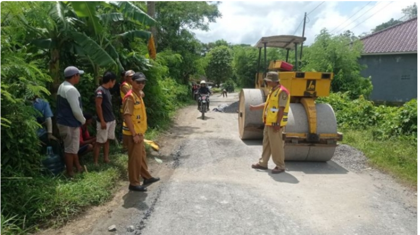
Dinas PU Kabupaten Sukabumi Perbaiki Jalan Rusak di Wilayah Jampangkulon.
