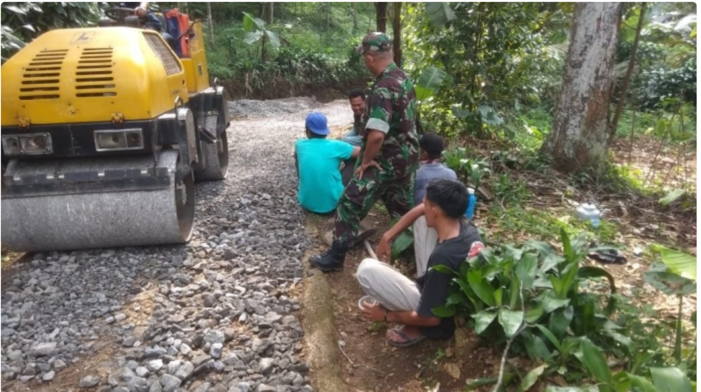
Babinsa Desa Pangkalan Monitoring Pembangunan Infrastruktur
